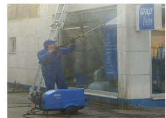
Fassadenreinigung m. HDR
